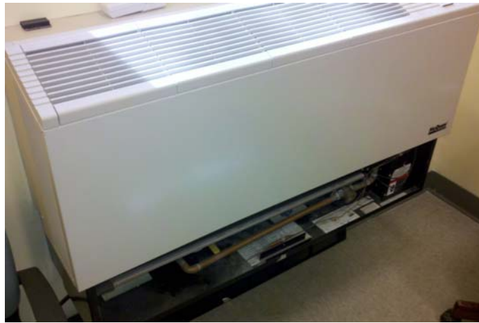
5: McQuay PTAC unit
